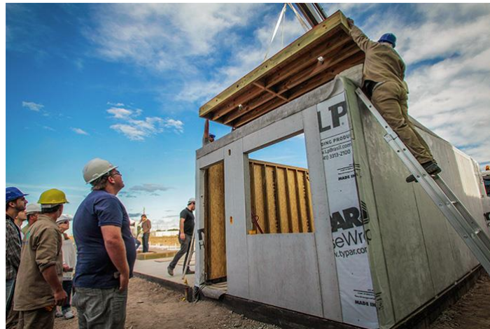
Figura 4. Montagem dos sobrados em woodframe , em Pelotas (RS)
