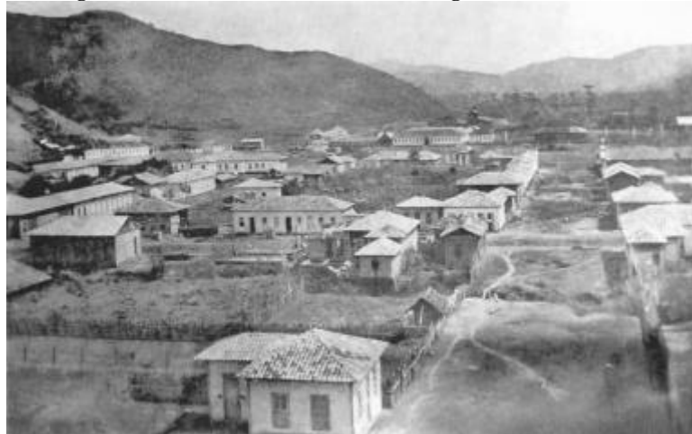
Figura 1 - Freguesia de Nossa Senhora da Saúde das Águas de Caldas (1886).
