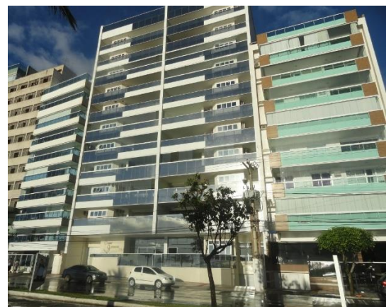
Figura 5: Edifícios da década de 1980 reformados.
