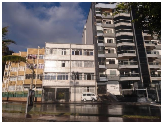
Figura 4: Edifícios construídos sem espaçamento entre o limite do lote e da edificação.
