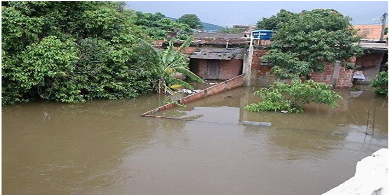
Figura 3 – Transbordamento do rio Ururáí
