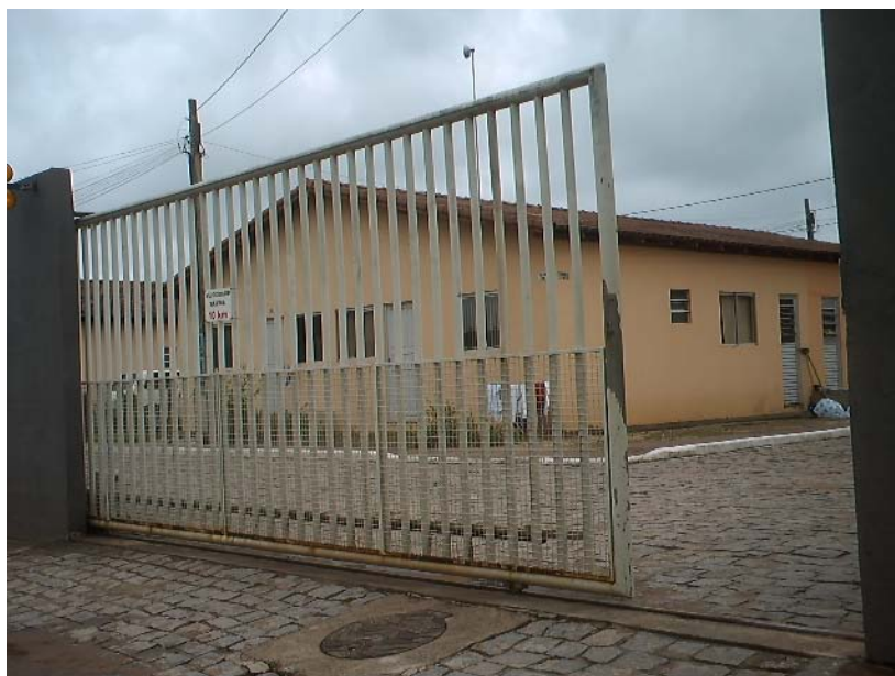
Foto nº 01: Portão de Acesso ao Condomínio Jacarenema Fonte: Acervo do Movimento Jacarenema- Em 18/10/10
